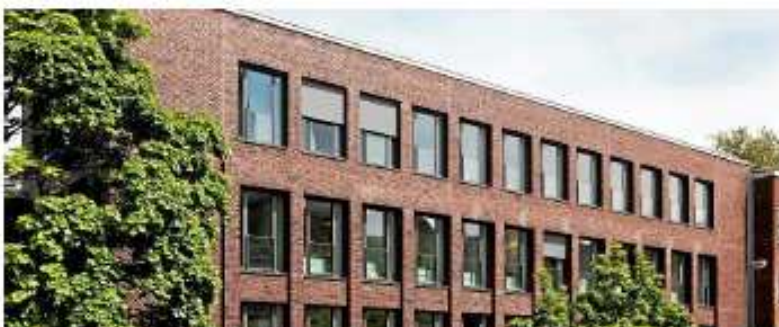
An der Apostelkirche 4, auf einer Fläche von mehr als 2000 m 2 , sind die umfassenden Kompetenzen an einem Standort mitten in der Innenstadt von Münster gebündelt.
